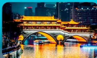
สะพานอันชุน
